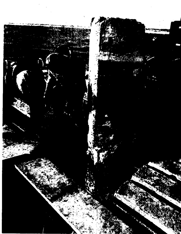
FOTO 04: Trabajos de unión viga-pilote
