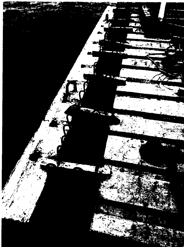
FOTO 11: Encofrado en la zona del cabezo
