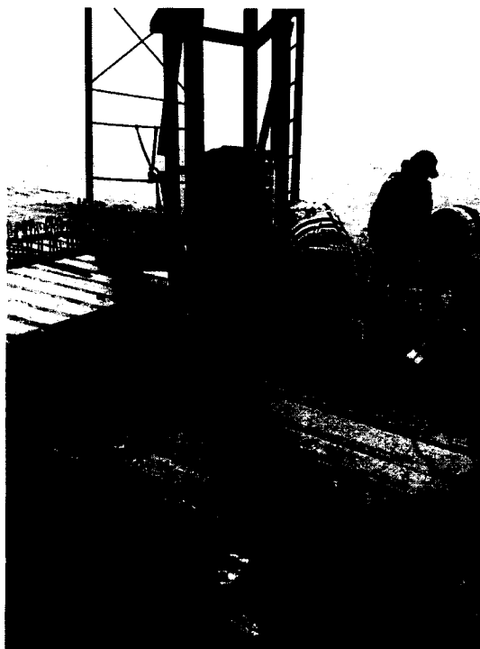
FOTO 02: Trabajos para el hincado de pilotes en los ejes de la zona del cabezo
