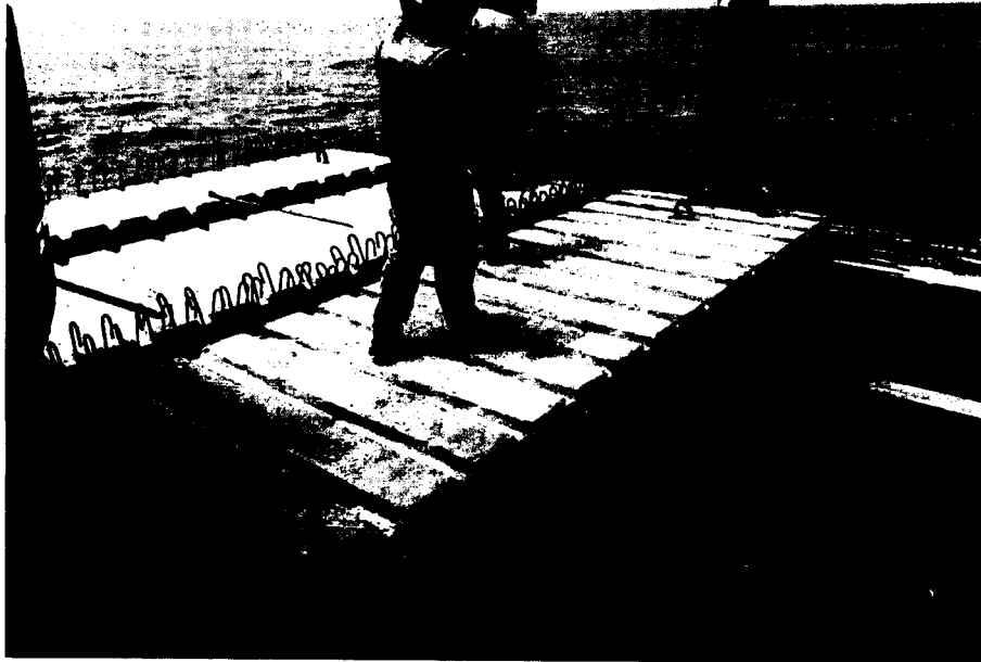
FOTO 07: Colocación de losas nervadas en la zona del cabezo
